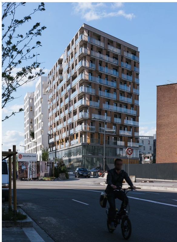
Lille (59) - immeuble mixte commerces/bureaux/ logements, contrôle des apports solaires des logements, structure porteuse poteaux-poutres avec cloisonnement intérieur léger modulable
