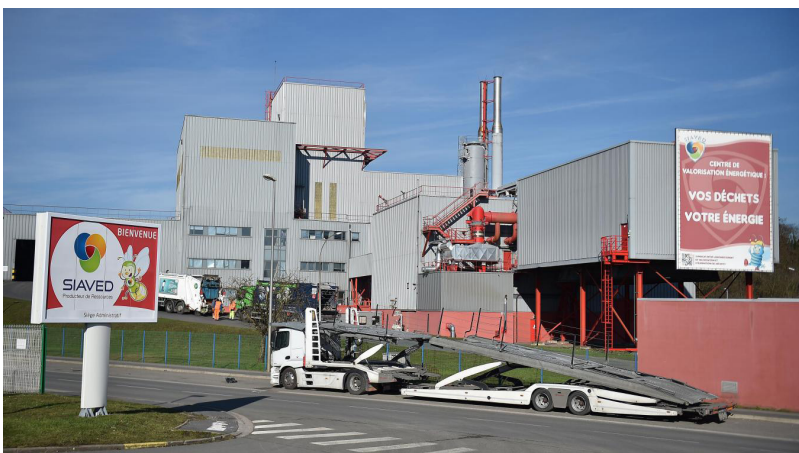
Douchy-les-Mines (59) - Centre de revalorisation énergétique pour alimentation du réseau de chauffage urbain
