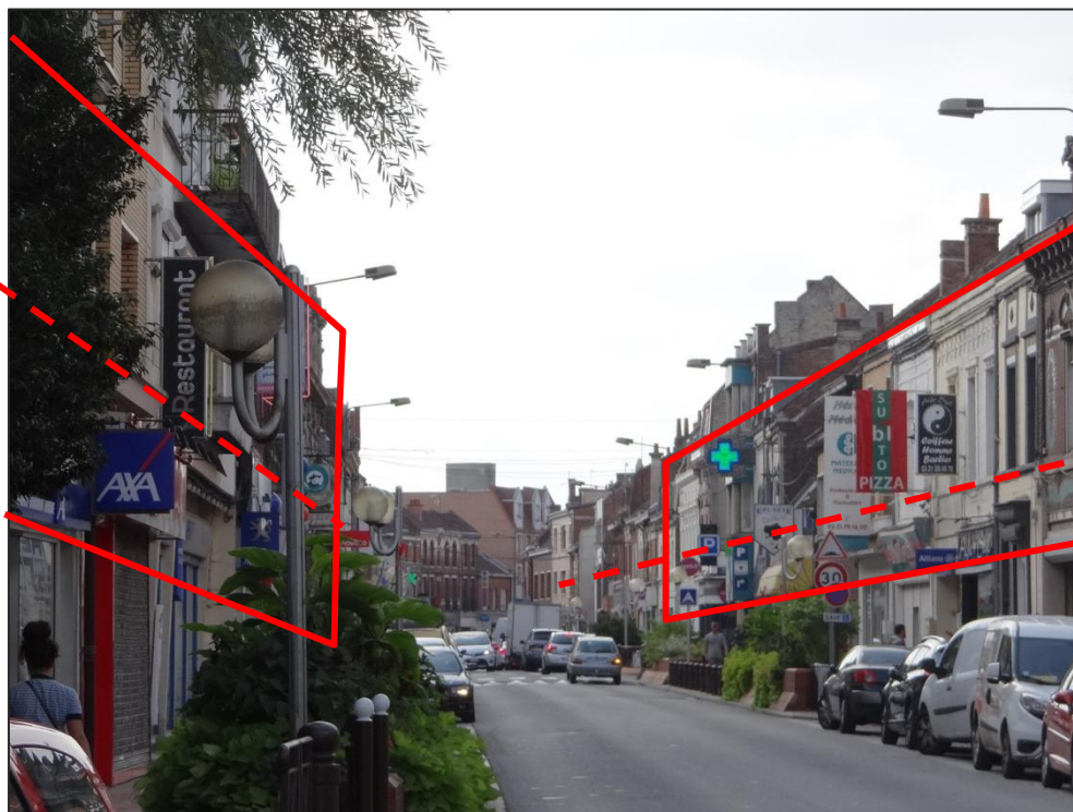
Enseignes en drapeau sur seconds étages avec un manque d'alignement entre les commerces.
