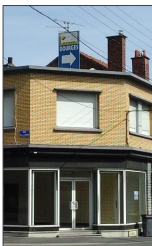
Pré-enseigne murale qui dépasse l'égout du toit
