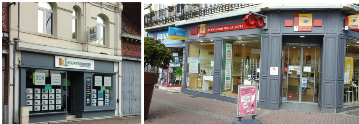
Exemple de dispositif « en drapeau » (perpendiculaire à la façade)
