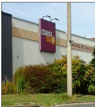
Enseigne murale avec hauteur max qui dépasse les limites du mur support
