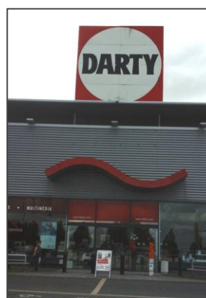
Enseigne en toiture avec hauteur max > 3m
