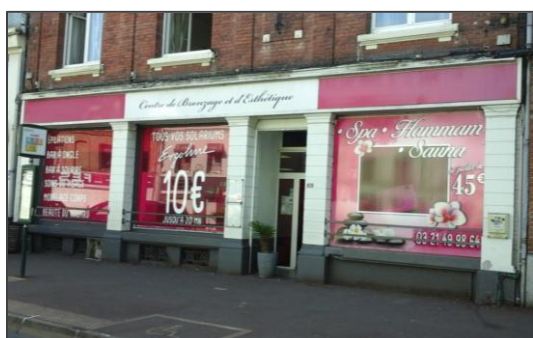
Enseigne murale avec surface cumulée des enseignes > 15% surface façade (si façade > 50m 2 )
