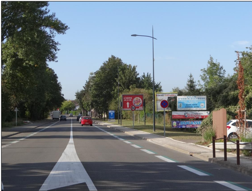
Entrée de ville Nord sur la RD919 : 6 panneaux au sol (1 avant la photo) + 1 mobilier urbain sur 100ml.
