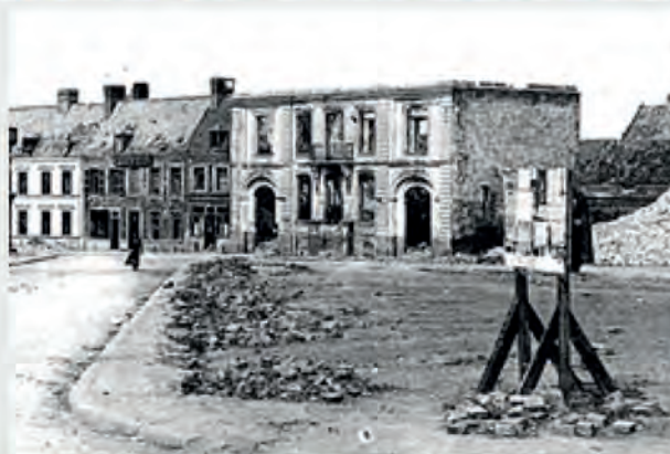
Place Carnot rue juste déblayée
