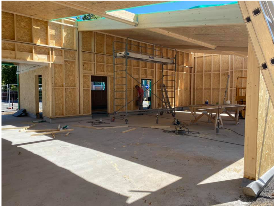
Ecole Pantigny - Ossature bois
