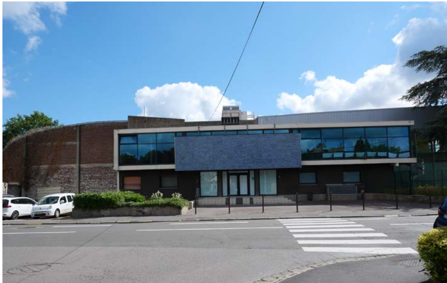
Fig. 142. Piscine Léo Lagrange
