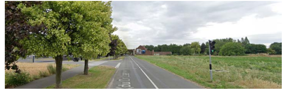
Fig. 103. L'entrée rue du Docteur Laennec avant l'A1
