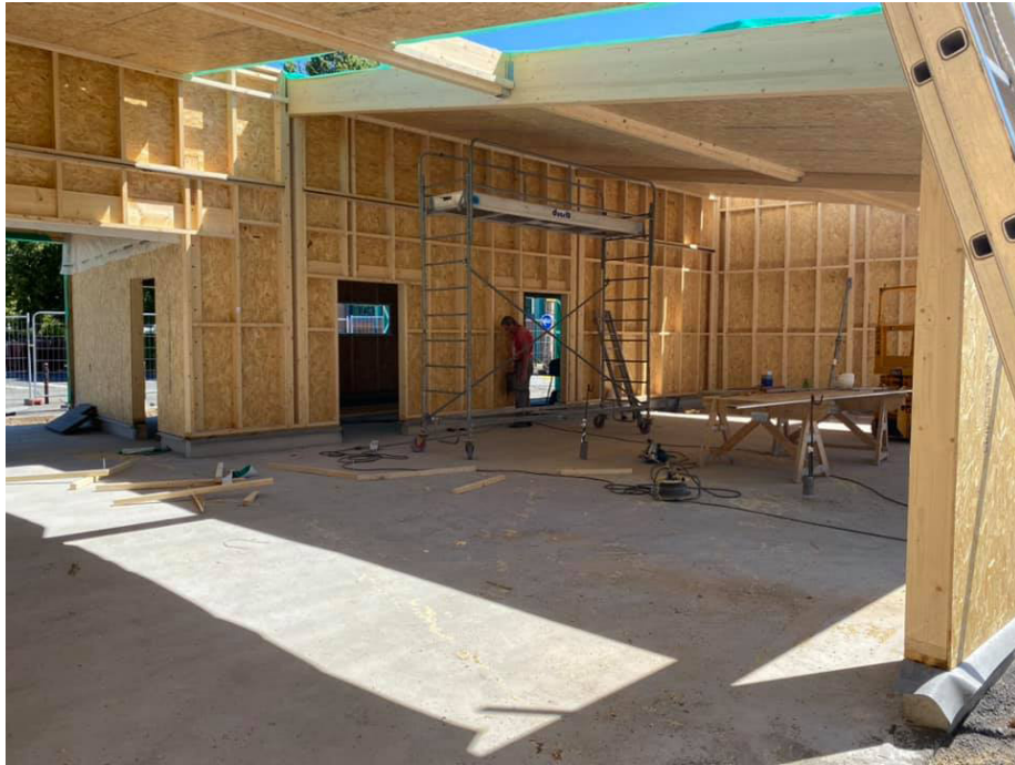
Ecole Pantigny - Ossature bois
