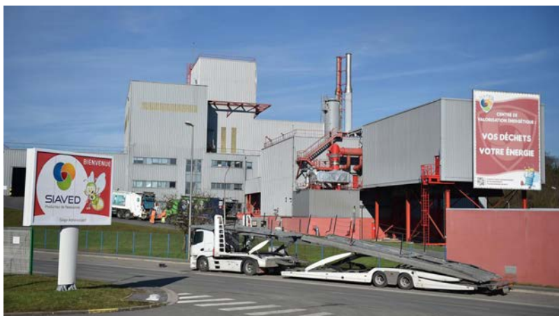
Douchy-les-Mines (59) - Centre de revalorisation énergétique pour alimentation du réseau de chauffage urbain
