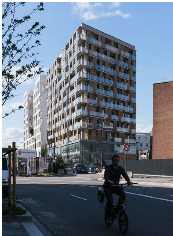
Lille (59) - immeuble mixte commerces/bureaux/ logements, contrôle des apports solaires des logements, structure porteuse poteaux-poutres avec cloisonnement intérieur léger modulable
